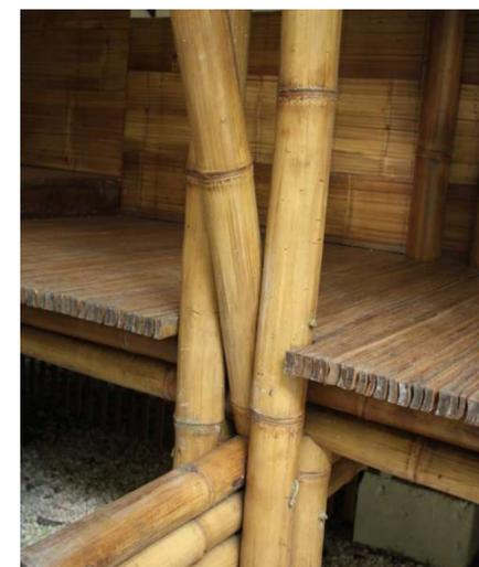
Fig.7 Collegamento pilastro-trave a terra
