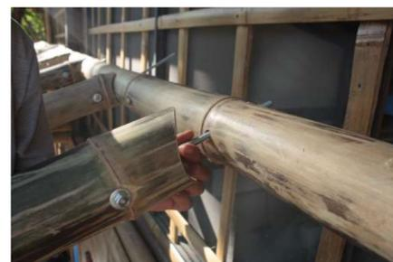
Fig.4 Dettaglio del collegamento a "bocca di pesce"
