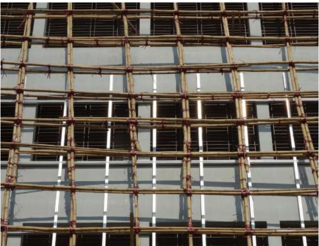
Fig.1 Impalcatura in bambù (Wikipedia)
