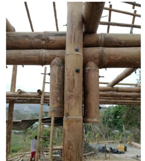
Fig.4 Dettaglio unione pilastro-solaio
